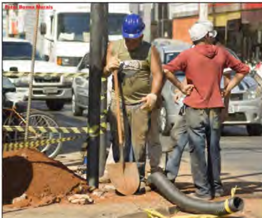
Funcionários da empreiteira preparam dutos para a cabiação
